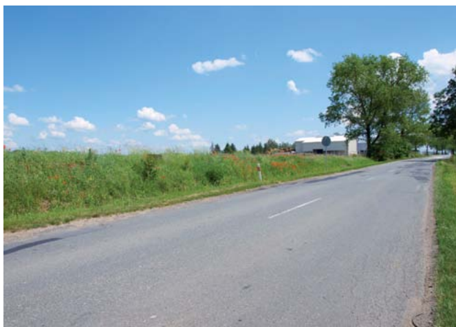
Widok z ulicy Kamienieckiej – przy działce prywatnej. Widok na drogę wojewódzką Nr 385. The view from Kamieniecka Street – next to the private property The voivodeship road No. 385 Ansicht von der Woiwodschaftsstrasse Nr. 382 aus Ebenfalls im Bild: Woiwodschaftsstrasse Nr. 382
